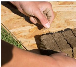
Große Bausteine lassen sich mit einem Stück Draht sehr gut in kleinere Steine schneiden.
